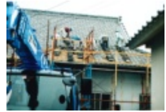
屋根瓦を取り除く
