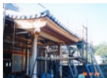
破風板の取り付け
