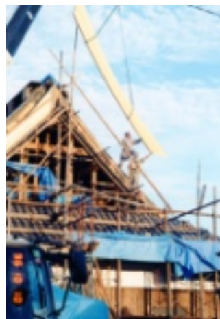
破風板の取り付け
