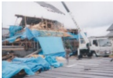
仮屋根設置作業
