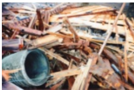
倒壊した四日市別院の鐘楼
