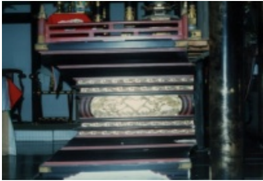
漆も柱の金箔も剥げている
